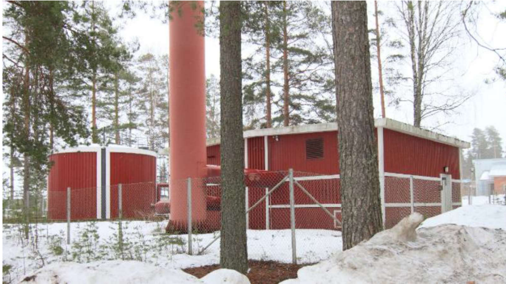
Kuva 8. Varalämpövoimalan rakennuksia sekä piippu.
