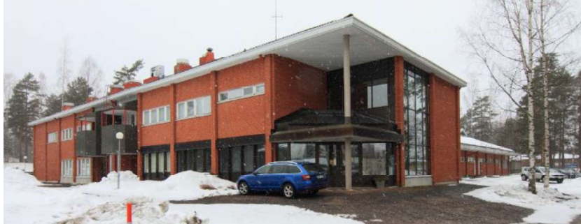
Kuva 16. 1990-luvun punatiilinen liike- ja toimistorakennus kaava-alueen pohjoispuolella Honkalantien varrella.
