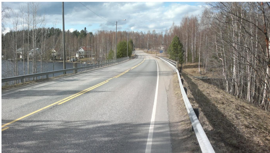
Kuva 19. Pusunvuolteen silta etelästä. Leveys sillan kohdalla 10,4 metriä.
