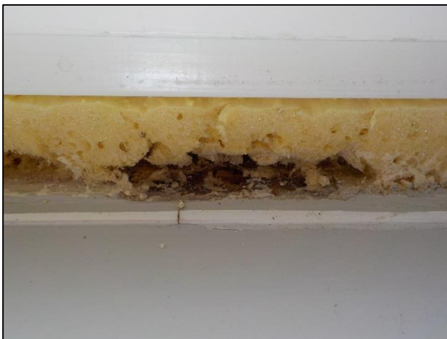
Kuva 4.8. Vasemmalla yleiskuvaa apukarmista rakenneavauksesta AUS-5, jossa apukarmi on tummunut. Oikealla kuva näytteestä A 22 (rakenneavaus AUS-4), jossa myös puu on tummunut kosteusra- situksen seurauksena.
