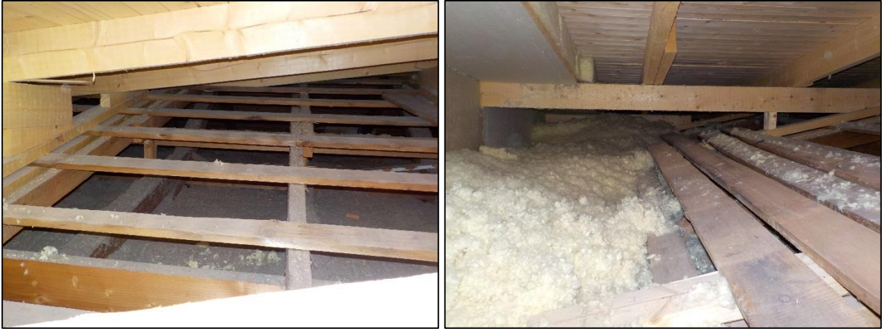
Kuva 4.17. Yleiskuvia yläpohjan rakenteesta: kuvat otettu terveystalokeskuksen siipiosasta. Yläpohja ei tutkitavissa lämmöneristettä vaurioittamatta.
