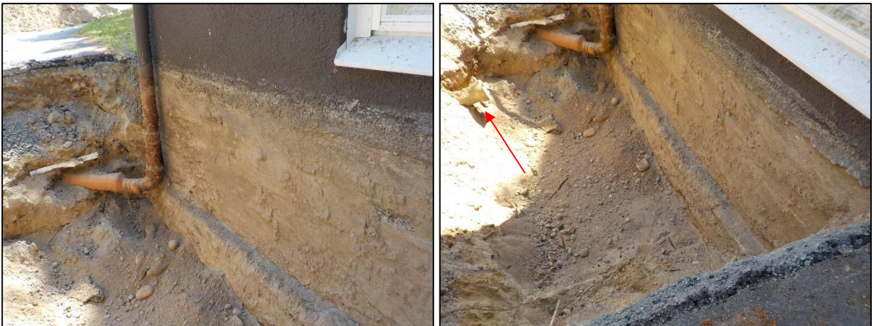
Kuva 4.1. Yleiskuvia koekuopasta KK-1. Kuopassa oli vanhan betonisen ruukkuputken pätkiä.
