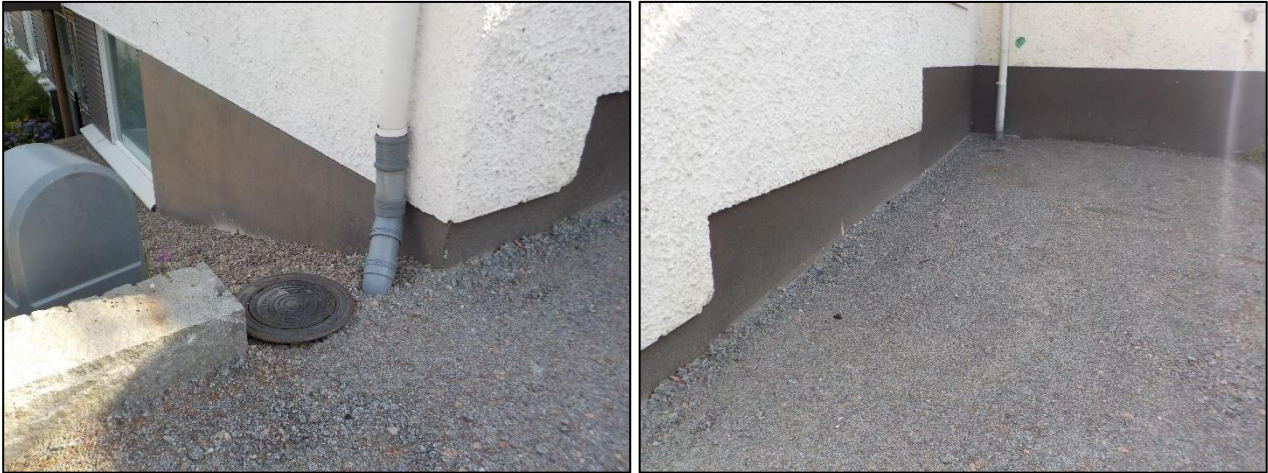
Kuva 4.2. Yleiskuvia kuivatusrakenteista korjatulta osuudelta: syökyjen vedet johdetaan umpiputkin sadevesiviemäriin. Perusmuurien vedeneristys ei ole havaittavissa.
