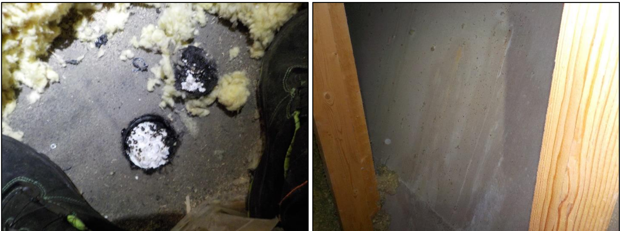
Kuva 4.25. Vasemmalla yleiskuva rakenneavauksesta AYP-5: nykyisen puhallusvillaeristeen alla on säilytettynä vanha porrashuoneen vesikattorakenne ja tämän kumibitumikermikate. Oikealla ilmanvaihtokonehuoneen kipsilevyissä näkyviä kosteusjälkiä rakenneavauksen AYP-6 läheisyydessä.
