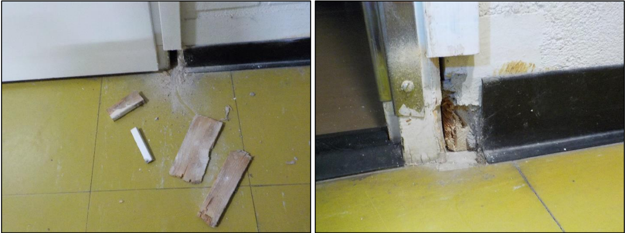
Kuva 4.7. Vasemmalla yleiskuvaa rakenneavauksesta AVS-2 ja oikealla rakenneavauksesta AVS-3.
