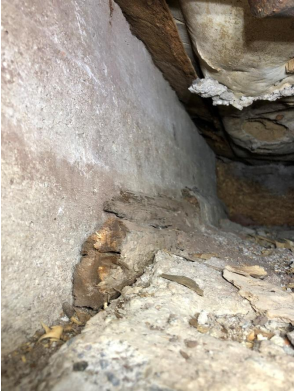
Kuva 20. Välipohjarakennetta tilan 048 kohdalla.
