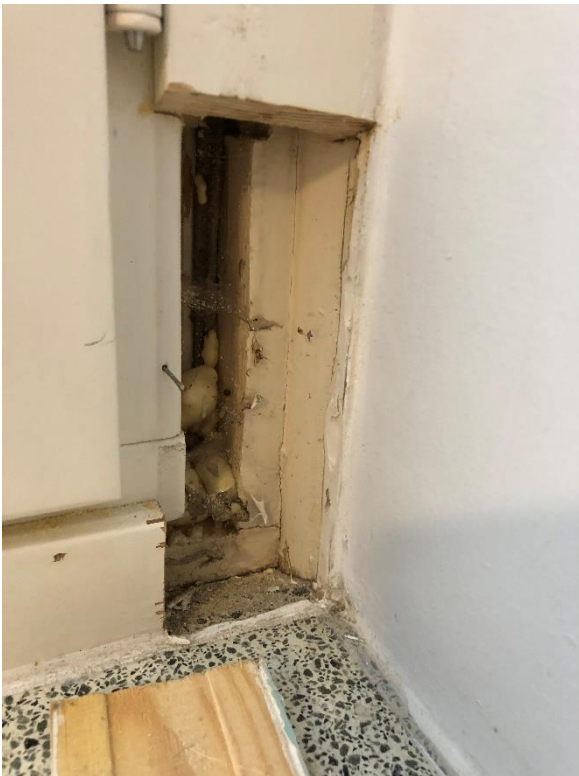
Kuva 33. Uudet ikkunakarmit asennettu vanhojen karmien päälle.
