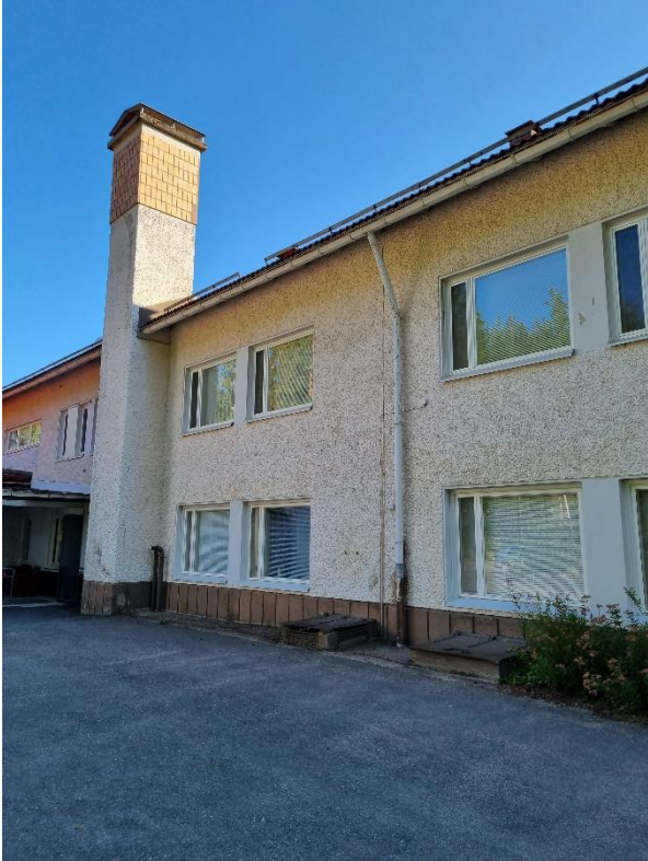
Kuva 25. Yleiskuva takapihan puolelta. Maanpinta lattiapintaa ylempänä (näytteet 15 ja 25, vertailunäyte 16 ylempää seinärakenteesta).
