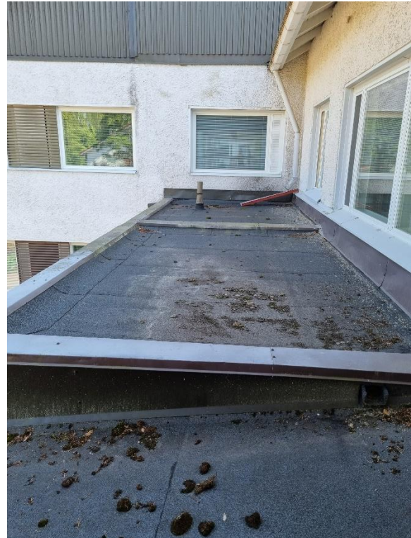
Kuva 40. Pääsisäänkäynnin huopakatteelle lammitoituu vettä isolta lappelta tulevan sadeveden vuoksi.
