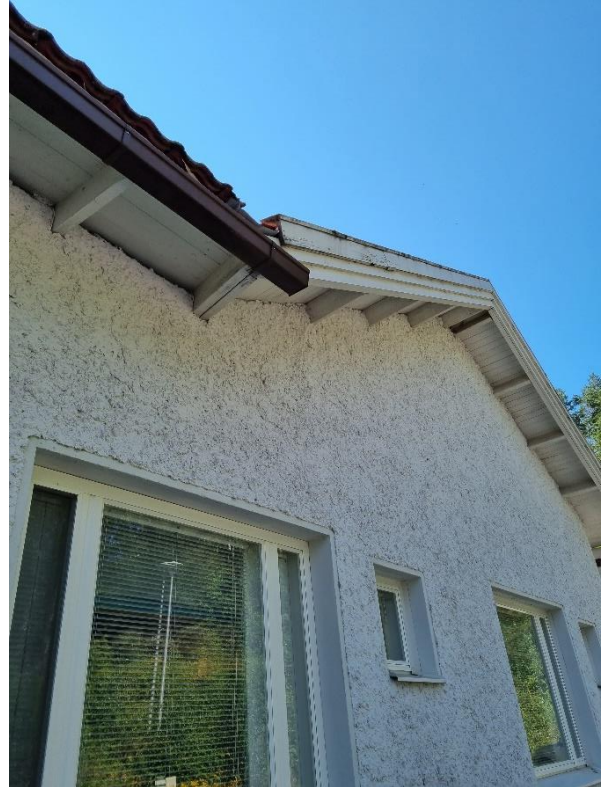
Kuva 26. Yleiskuva vesikaton liittymäkohdasta.
