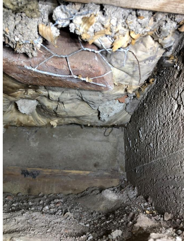
Kuva 21. Välipohjarakennetta tilan 048 kohdalla.
